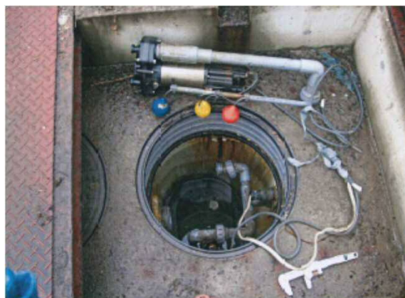
交換(撤去)状況
