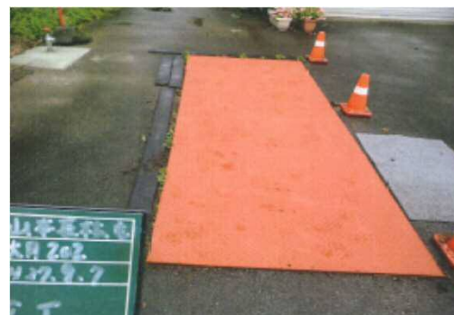
浄化槽ピット の蓋交換
