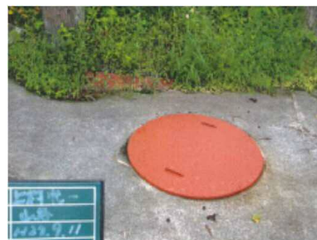
放流ポンプ槽 の蓋交換
