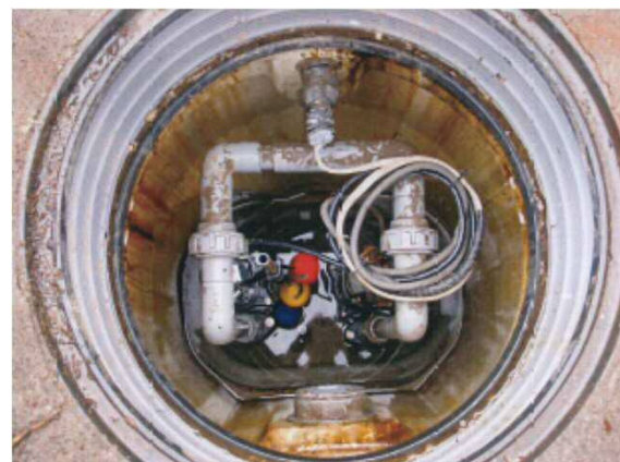
復旧完了状況
