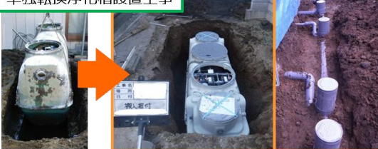
単独浄化槽撤去 合併浄化槽設置 配管工事
